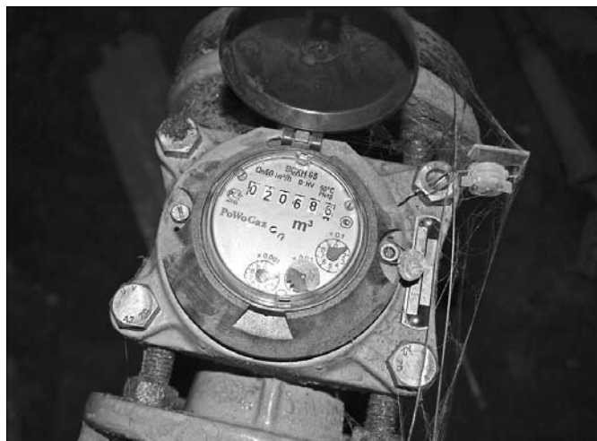
Установлен общедомовой счетчик на холодную воду.
