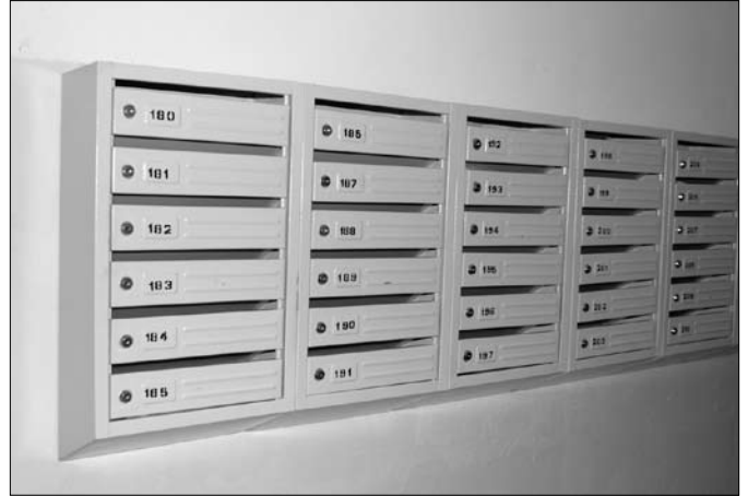
В подъездах провели косметический ремонт, заменили почтовые ящики.
