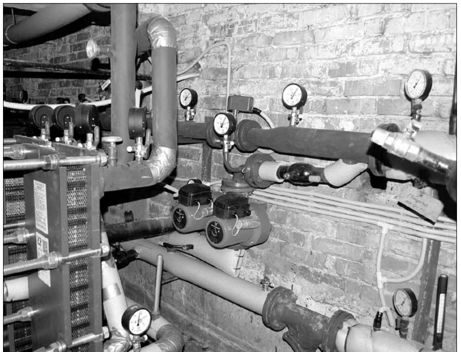
В домах, оборудованных автоматическим тепловым пунктом, равномерно отапливаются все квартиры: и угловые, и те, что в центре.
