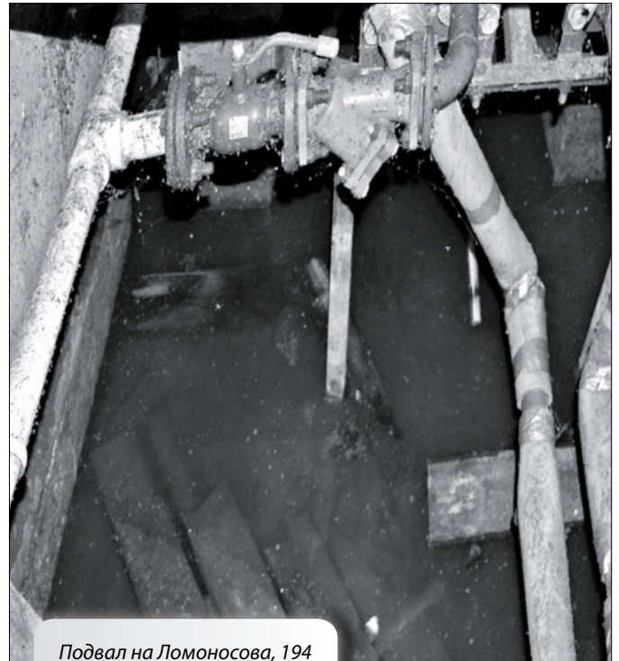
Подвал на Ломоносова, 194 полностью затоплен.
