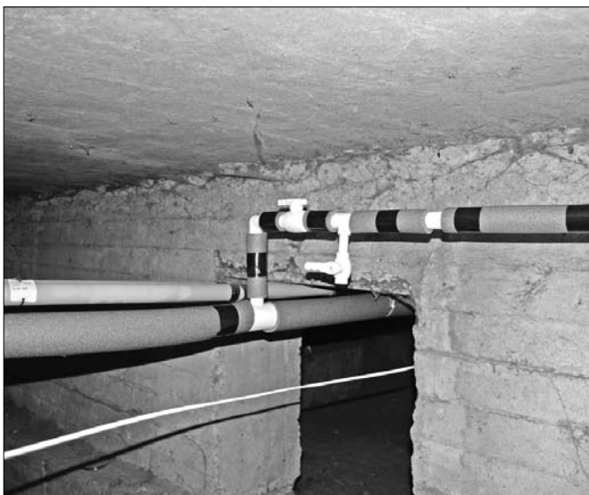
На Шабалина, 22 заменили розлив горячего водоснабжения в 4,5 и 6-м подъездах. В доме также будет смонтирован автоматический тепловой пункт.
