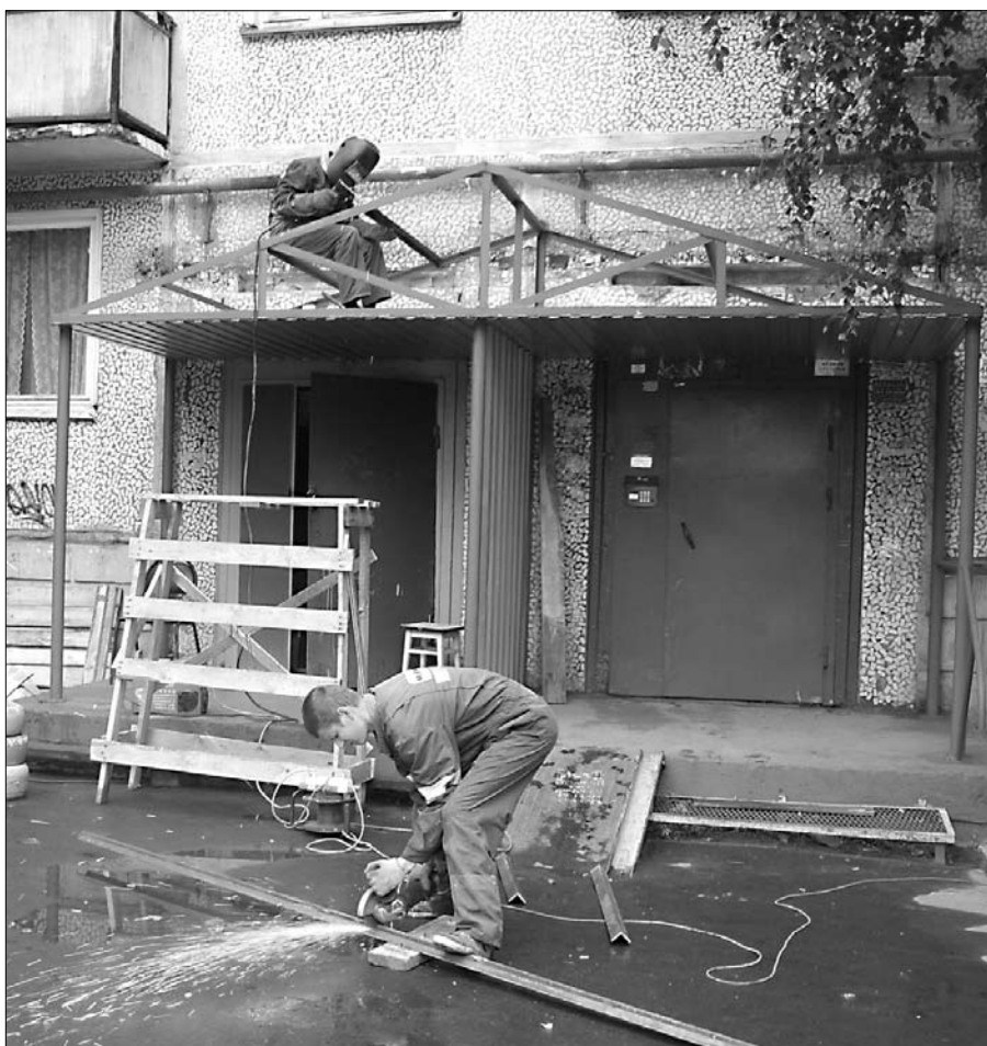
На Воронина, 39 рабочие монтируют козырёк над 3-м подъездом.
