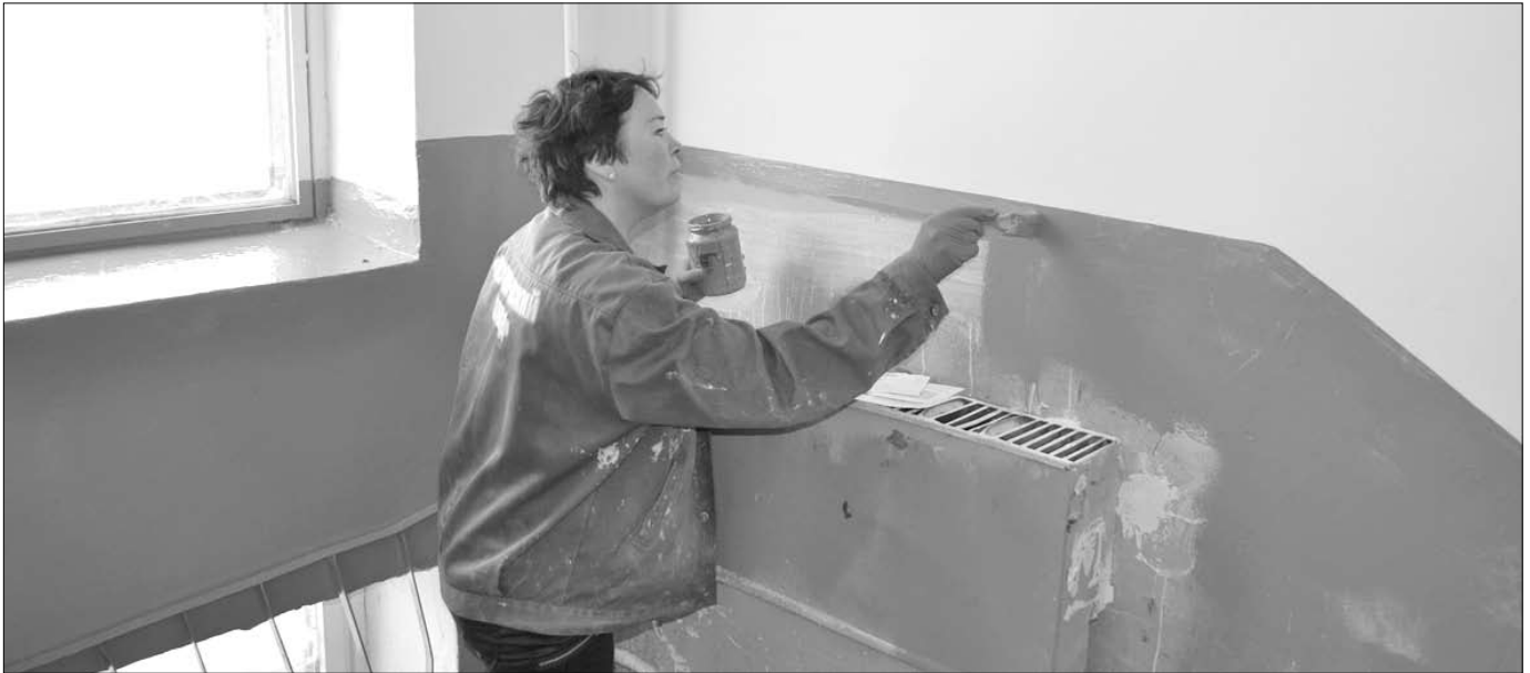
На Садовой, 40 полным ходом идёт косметический ремонт в 1 и 2-м подъездах.
