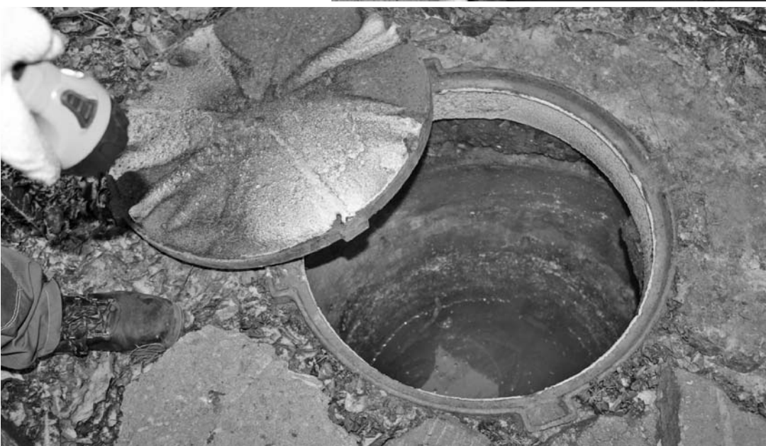
Подвалы на пр. Ломоносова, 194 затоплены более четырёх месяцев. Стокам просто некуда уходить из канализационных колодцев.
