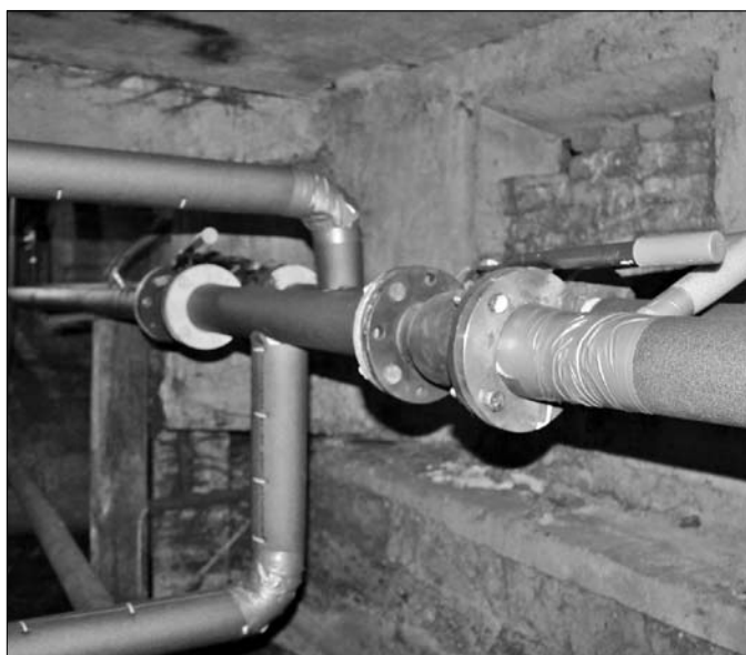
Одними из первых в округе жители дома на Воронина, 31, корп. 3 приняли решение снять средства со спецсчёта на проведение капитального ремонта. В многоэтажке уже заменили розлив отопления.
