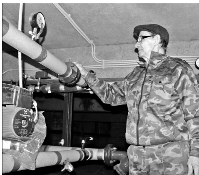
Член Совета дома Ю.В. Хандов ежедневно осматривает все инженерные коммуникации в многоэтажке, чтобы свести к минимуму возможность аварийных ситуаций.
