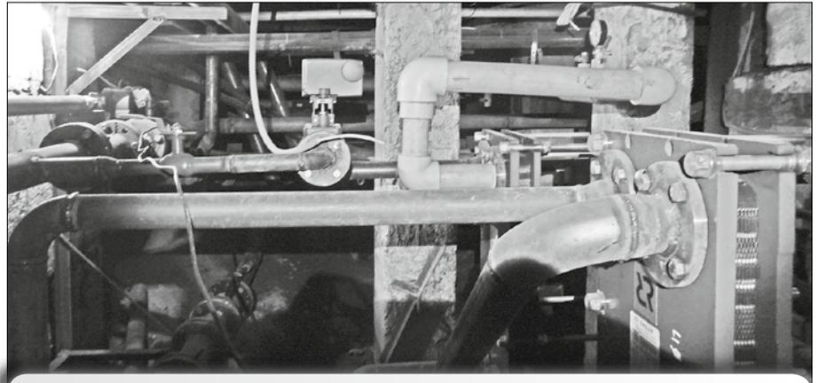
*Автоматический тепловой узел на Ленинградском, 265, корп. 2 смонтировали этой осенью, специалисты продолжают его отладку.*
