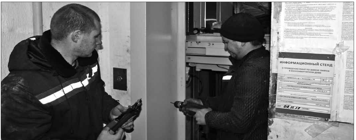
Заканчивается монтаж нового лифта на Ломоносова, 90.
