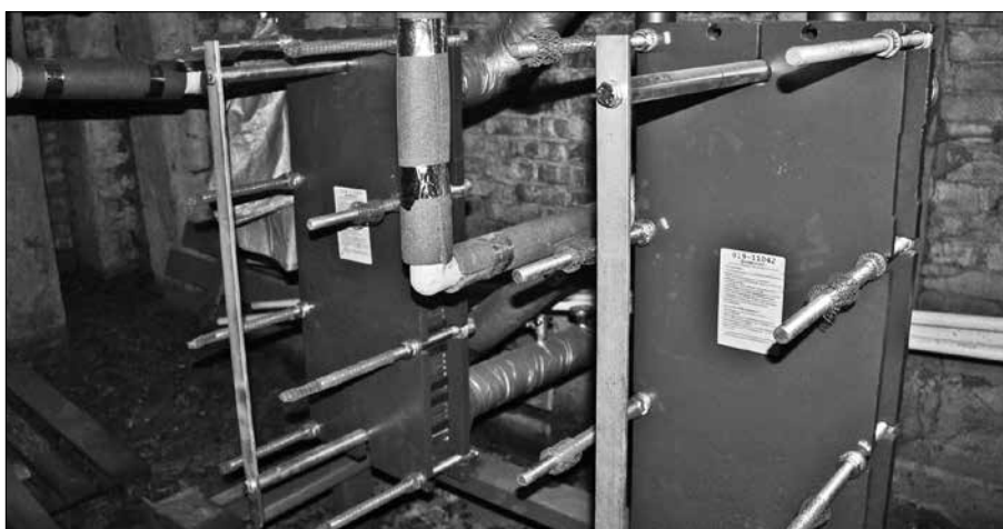
На средства капитального ремонта, накопленные на специальном счёте, устаревший скоростной водоподогреватель был заменён на современный пластинчатый теплообменник марки «Ридан».
