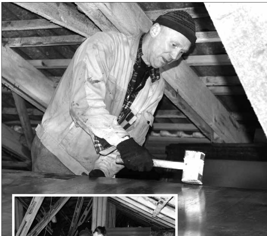
На Ломоносова, 285 работчие СМП ремонтируют кровлю. Чинить скатные крыши можно в любое время года.
