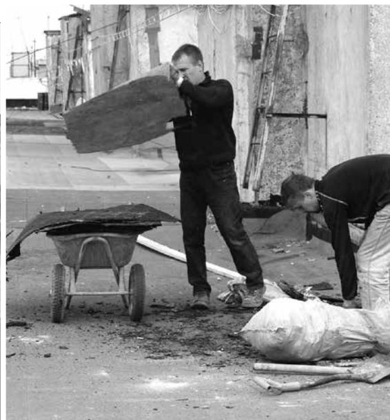
Этим летом силами СМП отремонтирована часть кровли на Ленинградском проспекте, 356. Средства собственники накопили на специальном счёте.
