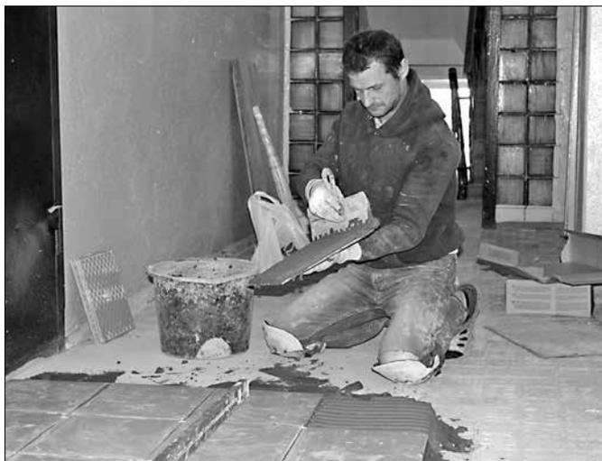
На Тимме, 8, корп. 2 делают косметический ремонт в подъезде, на пол укладывается плитка.
