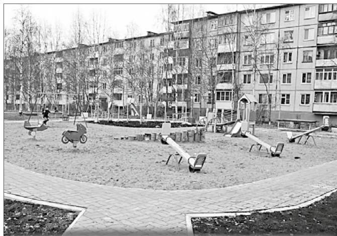
Дзержинского, 3, корпус 1 и корпус 3
