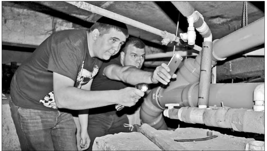
Ремонт розлива канализации на Ленинградском, 356 выполнен ООО «СМП». Компания много лет сотрудничает с управляющими компаниями Архангельска и успела зарекомендовать себя как надёжный подрядчик.
