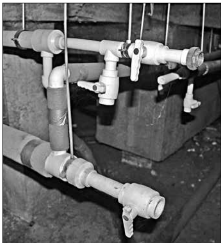
Розливы водоснабжения на Дзержинского, 3, корп. 1 после ремонта.
