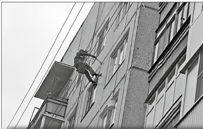
*На Новгородском, 41 производится утепление межпанельных швов.*
