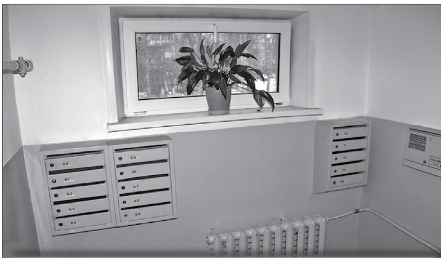
В 5-м подъезде Красных Партизан, 12 свежий косметический ремонт и стеклопакеты.
