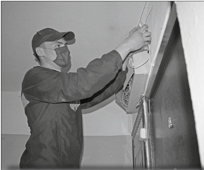
Специалист ООО «Архэнергоаудит» М. С. Богданенко выполняет ремонт электрооборудования на Ломоносова, 285, корп. 1.
