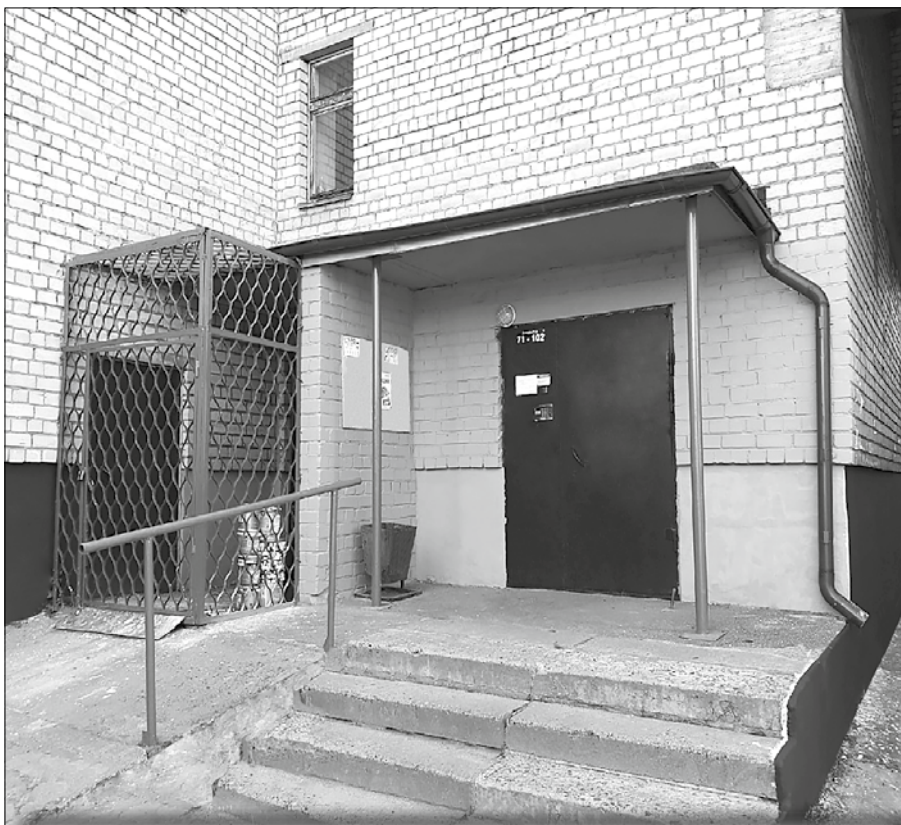
Размер платы, установленный на Московском, 4, корп. 1, позволяет регулярно проводить работы по благоустройству. В этом году в доме выполнили покраску цоколя и отремонтировали входные группы.
