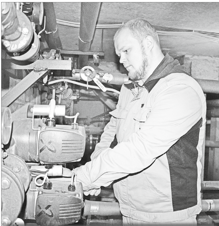
Начальник участка ООО «УК Майская Горка» Н.А. Калинин производит ревизию теплового пункта на Дачной, 42.
