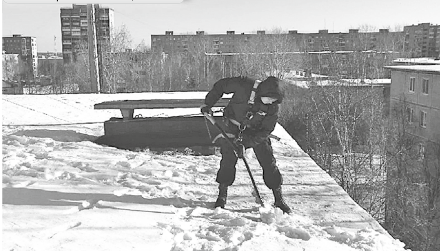
Чистка кровли на Тимме, 18.
