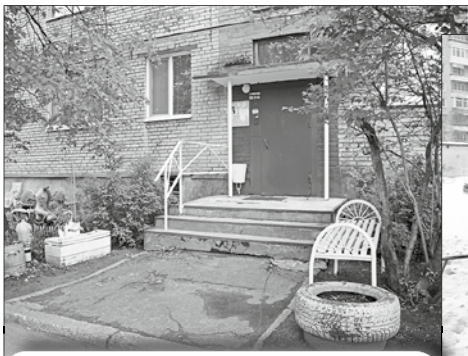
На Воскресенской, 105, корп. 1 выполнена окраска входных групп и скамеек.
