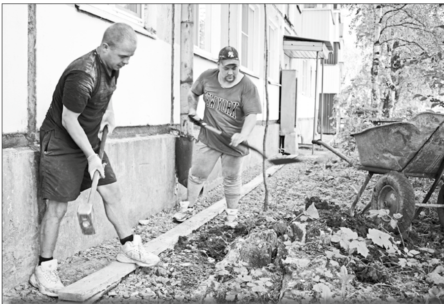
На Комсомольской, 43 ремонтируют отмостку по периметру дома.
