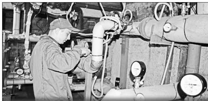
На Сов. Космонавтов, 37 монтажник санитарно-технических систем и оборудования П. Э. Пломядян производит установку манометров после проверки.
