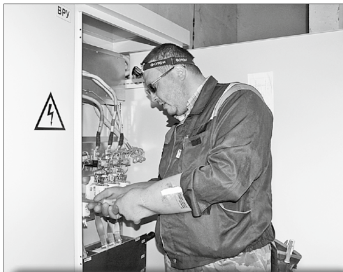
Электромонтёр ООО «РСК «Метелица+» С. А. Логуновский проводит осмотр вводно-распределительного устройства на Советской, 19, корп. 1
