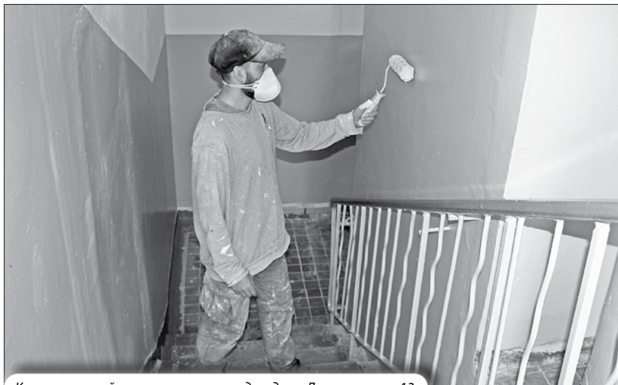
Косметический ремонт в пятом подъезде на Дзержинского, 13
